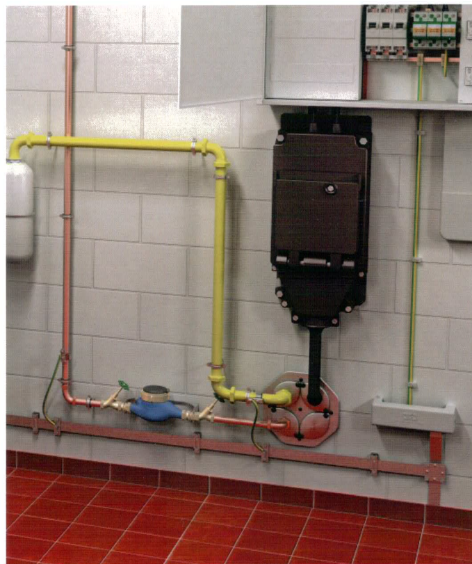
Obr.: Vyrovnanie potenciálov podľa STN EN 62305-3
